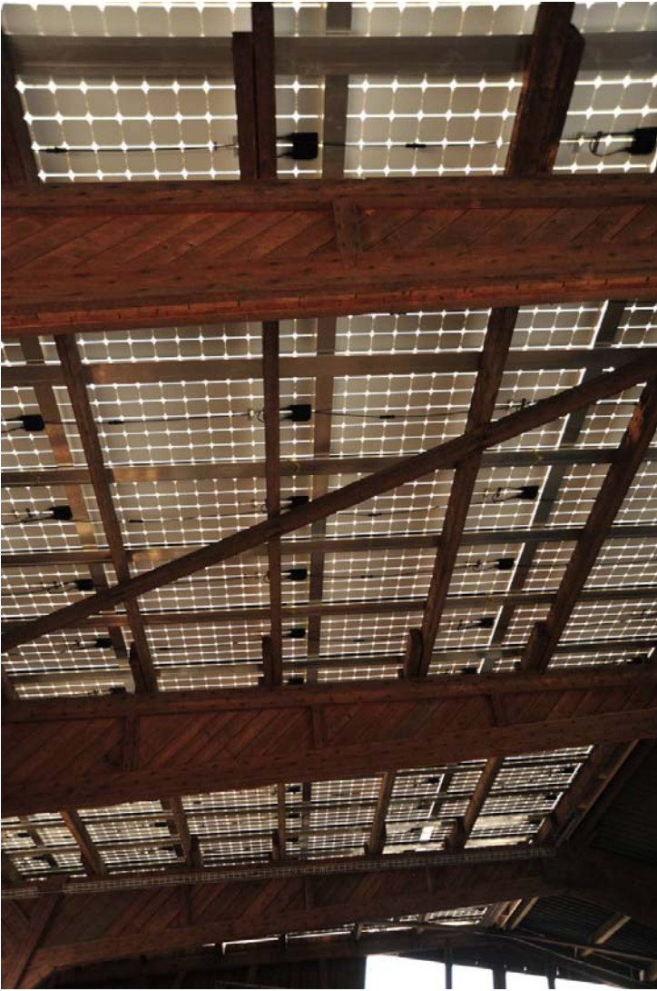
Dach von innen
