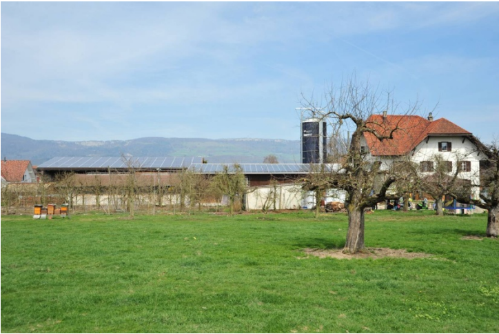
Dach Landwirtschaftsbetrieb Stüdi
