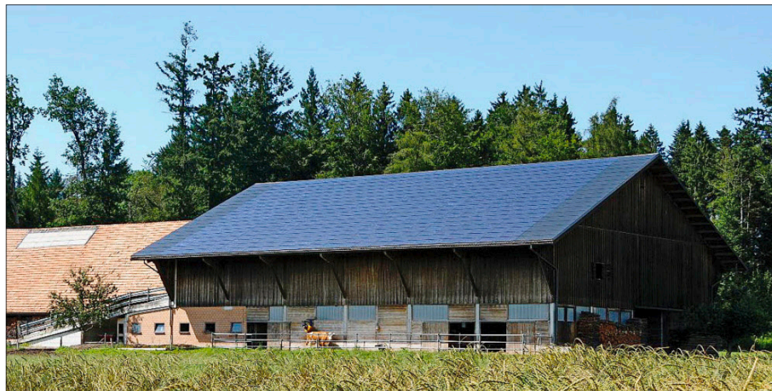
Bereits weitverbreitet sind Photovoltaikanlagen auf Scheunendächern. (Bild: hhn)
